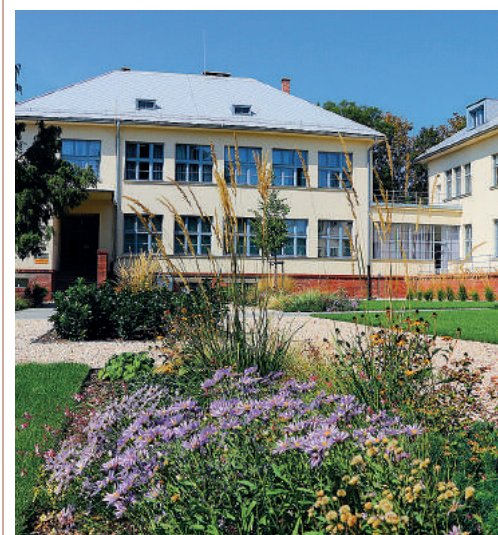
Areál FZKI na Hospodárskej ulici
