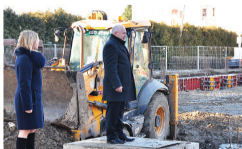
Stavenisko v rámci interného kontrolného dňa navštívil aj rektor SPU prof. P. Bielik Foto: za
